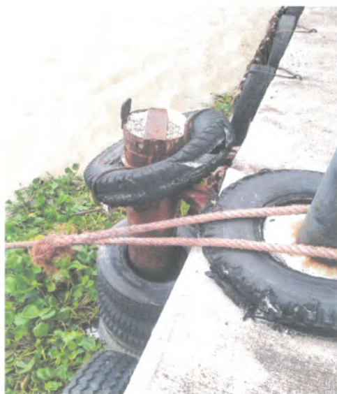
ภาพแสดงกันกระแทกและหลักผูกเรือสภาพดี แข็งแรง
