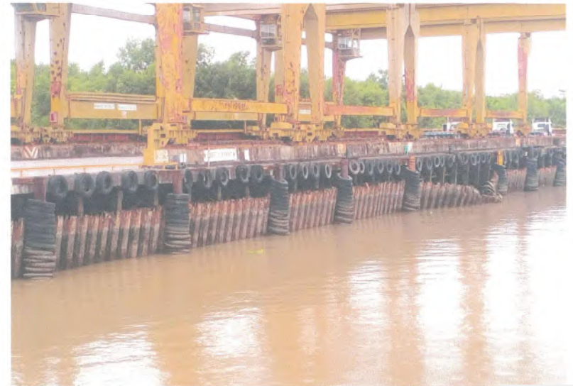
ภาพแสดงด้านหน้าโครงสร้างที่เป็นแนวได้ระดับ ไม่ทรุดเอียง
