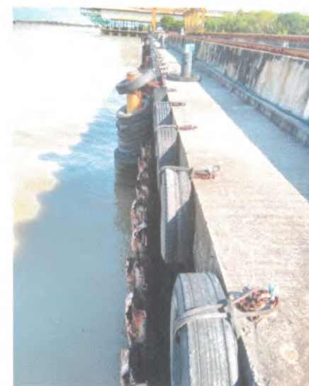
ภาพแสดง หน้าทำที่แข็งแรงไม่มีรอยแตกร้าว ไม่ทรุดเอียง
