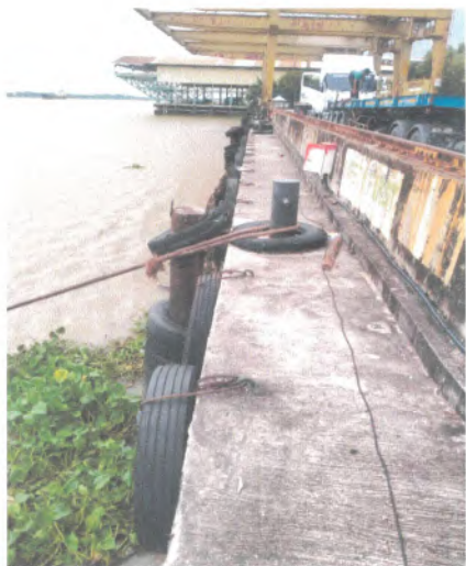
ภาพแสดงด้านหน้าโครงสร้างที่เป็นแนวได้ระดับ ไม่ทรุดเอียง
