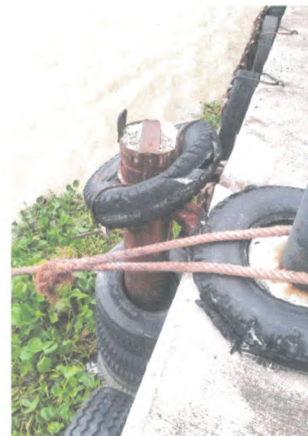
ภาพแสดง หน้าท่าที่แข็งแรงไม่มีรอยแตกร้าว ไม่ทรุดเอียง กันกระแทกแข็งแรง
